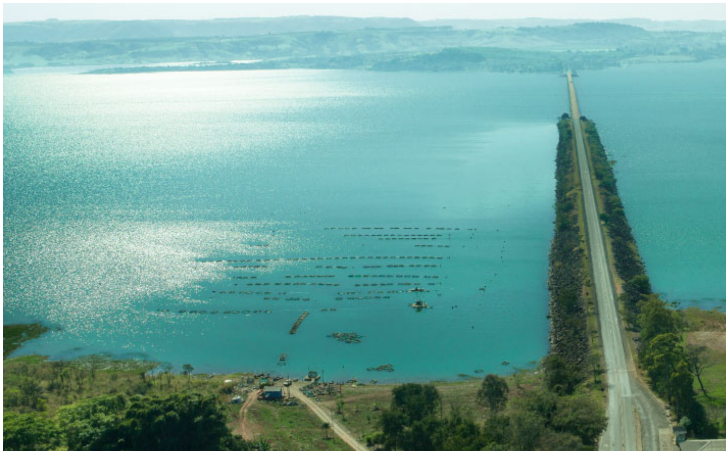
Aterro e Ponte Interestadual - Foto: Prefeitura de Carlópolis
